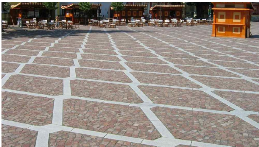
A Széchenyi tér meglévő burkolata
