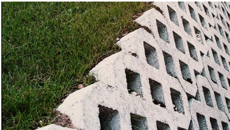
Szikkasztóárók lehetséges kialakítása - részlet
