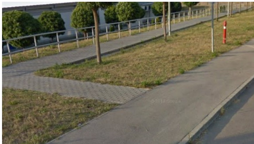
Aszfalt és térkő járda, kiemelt szegéllyel
