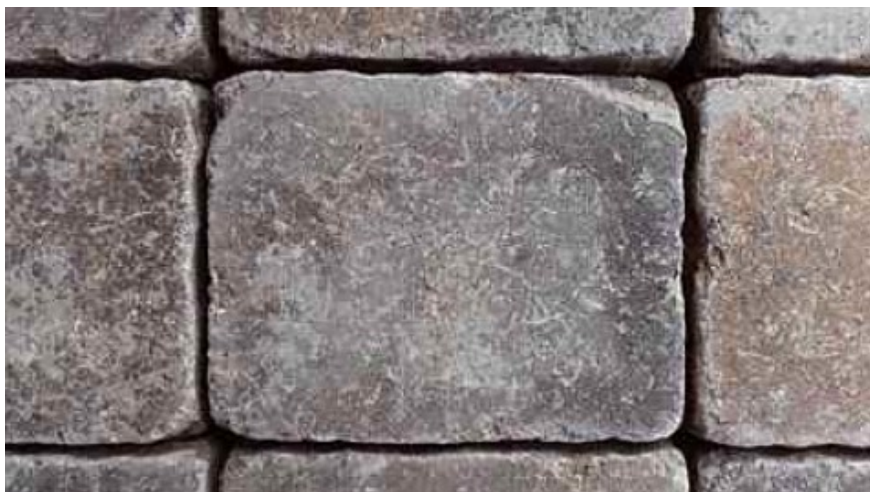
Azonos méretű antikolt beton térkő, hálóra rakva
