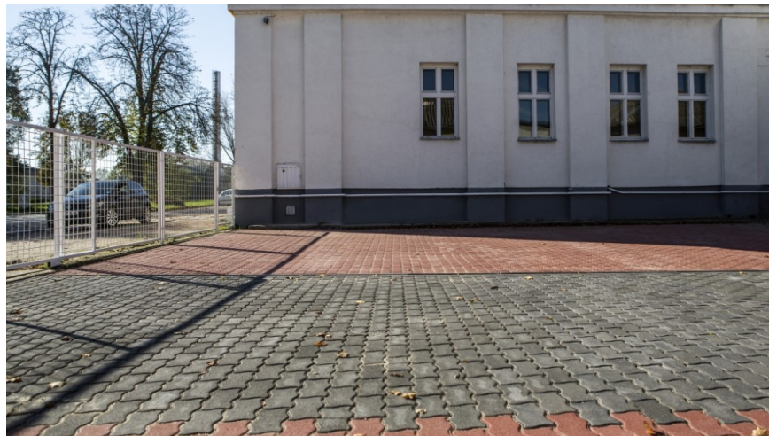
Többszörös kapcsolódású beton térkő parkolóban
